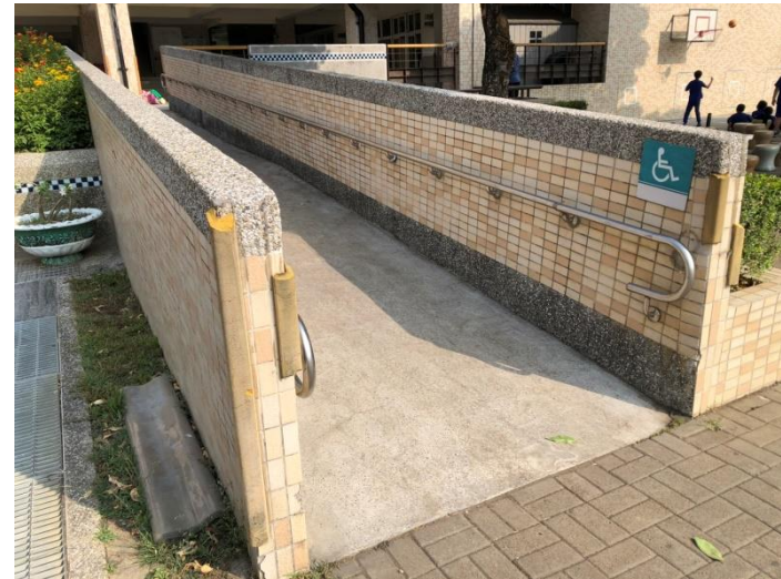
設施名稱：無障礙坡道
