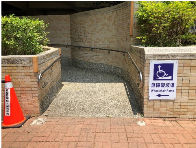
設施名稱：無障礙坡道
